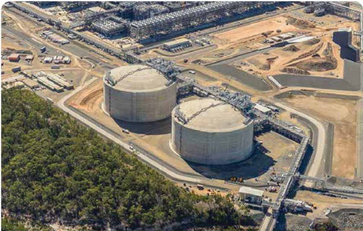
LNG storage tanks on Curtis Island
